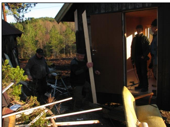
Restaurering av startbua i lysløypa, Øyangen.
